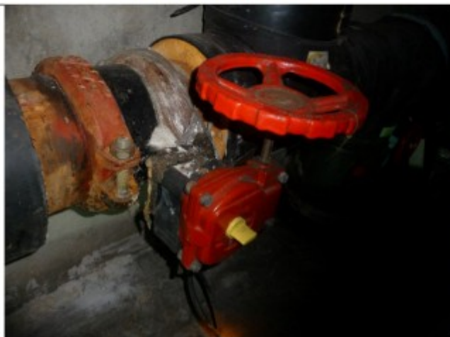
147m du P.I. 0499 : Vanne BAN 02 C PAM purge simple fonction PAM. Piquage vers le haut. Réseau corrodé
