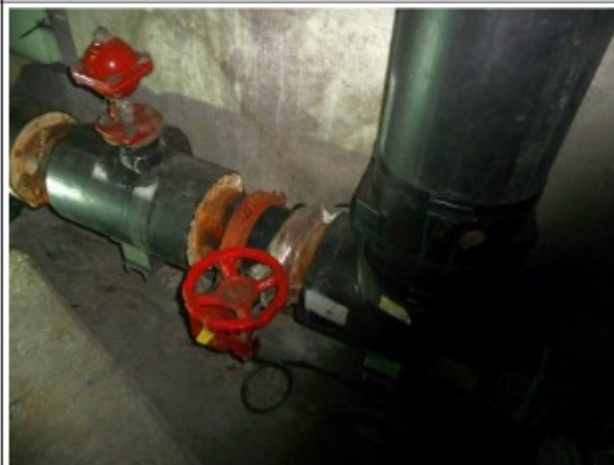
147m du P.I. 0499 : Vanne BAN 02 C PAM purge simple fonction PAM. Piquage vers le haut. Réseau corrodé
